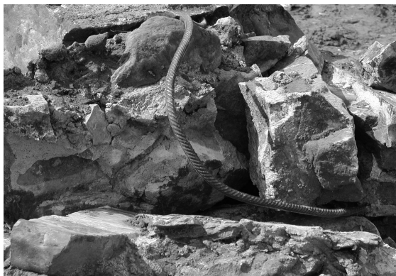
Afb. 9. Ijzeren staven in de fundering.
