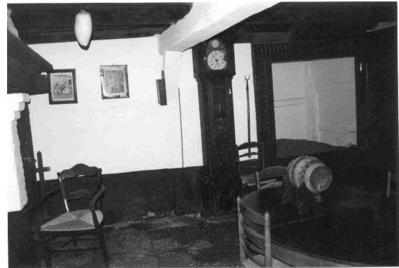
Afb. 6. De klokkenkast ondersteunt de zoldering.
